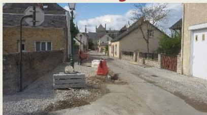
Les travaux réalisés en bas de la rue Angevine permettront aux piétons, avec des trottoirs de 1 m 40 de largeur, de circuler en toute sécurité et de ralentir la vitesse des véhicules. Nous avons pris en compte les remarques des riverains tout au long des travaux. Ce chantier s'achèvera à la fin du mois de mai 2017 et dans la continuité la partie haute de la rue Angevine sera également refaite. Je vous remercie encore de votre compréhension pour la gêne occasionnée pendant la durée des travaux.
