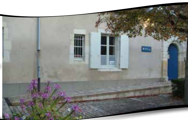
Installation d'une rampe d'accès à l'abbaye Saint-Pierre
